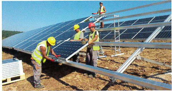
Montage de panneaux sur la centrale de Sanguinet (Landes - 40)
