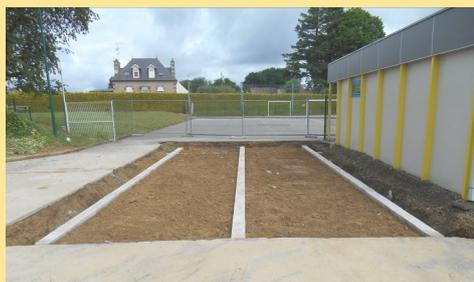
Les travaux de la 7<sup>o</sup> classe ont commencé à l'école. Les fondations ont été réalisées. La structure sera montée le 7 juillet et les finitions devraient être achevées vers le 17 juillet !
