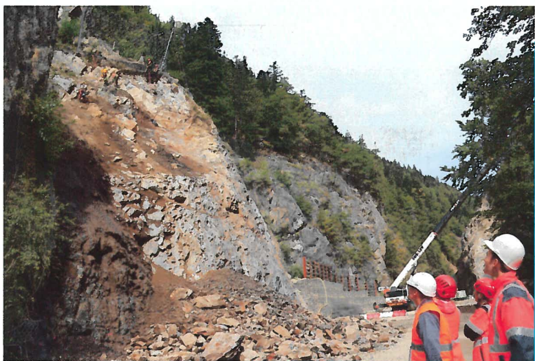
Sécurisation de la falaise du secteur Culdechien
