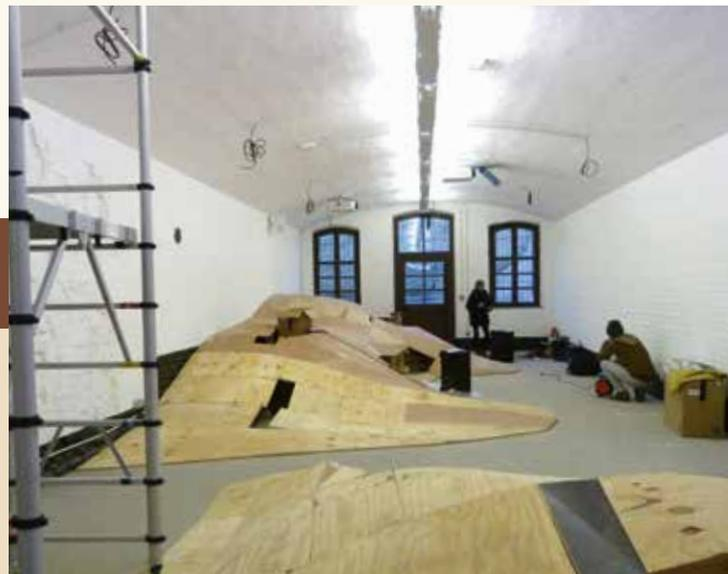
Après avoir également revu l'installation électrique dans la perspective de la scénographie, la réfection des sols a suivi : ragréage de l'ensemble des sols à l'intérieur du Fort (une surface globale de 800 m<sup>2</sup>) et coulage d'une résine spécifique en finition. L'accès sera ainsi uniformisé et plus adapté pour déambuler convenablement dans les salles et couloirs.
