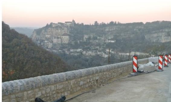
Engagé depuis 2013, le programme de réparation des murs et perrés qui bordent la route était échelonné sur 4 ans. C'est un budget d'un million d'euros qui a été consacré à la reconstruction en l'état de plus d'un kilomètre de murs parapets et au renforcement de quelques 5 000m<sup>2</sup> de talus perrés souvent cachés sous la végétation.
