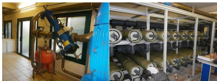
Station de Cabouy : aperçu du ballon anti-bélier et préfiltre. Les eaux préfiltrées sont ensuite filtrées sur les membranes.
