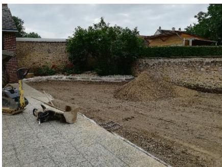
L'accessibilité de la cour de la Mairie a été renforcée en remplaçant les gravillons par du béton désactivé.
