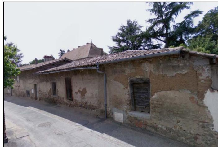
Le mur, réalisé en pierre, en pisé et en briques rouges est sur certaine partie dégradé, sa réhabilitation et son prolongement n'ont pas respecté les matériaux traditionnels (utilisation d'enduit couleur coquille d'œuf, de moellons...). Il semble toutefois important de le sauvegarder comme élément patrimonial, témoignage du passé.
