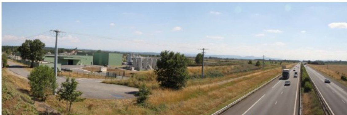
2.Gravières et site d'étude depuis la D10g enjambant l'A64 Source : L'Artifex, Juillet 2016
