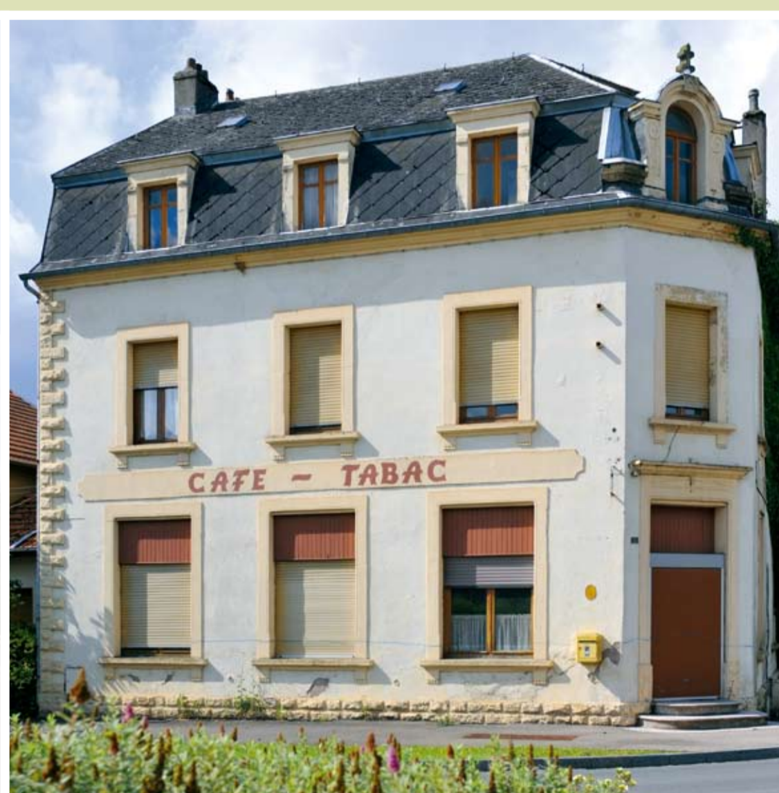
Ludelange, 11 rue Nationale, ancien café, actuellement immeuble de logements
