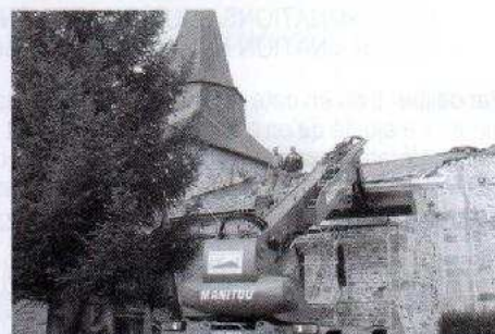
Réfection couverture de l'église
