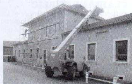
Réfection couverture école
