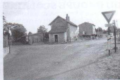
Vue d'ensemble immeuble PRADEAU
