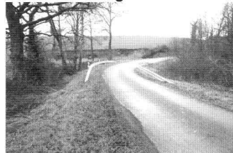
Pont de Lavergne
