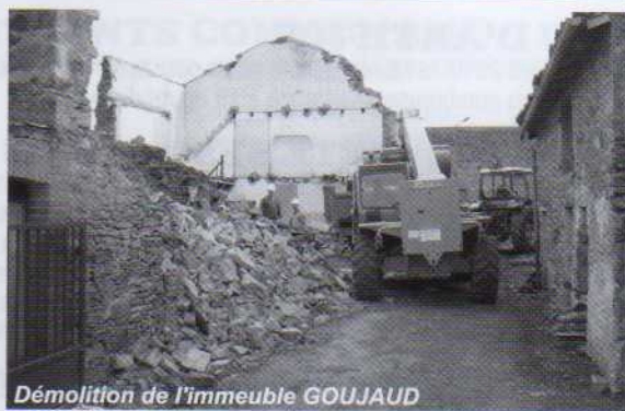
Démolition de l'immeuble GOUJAUD avant l'agrandissement du groupe scolaire
