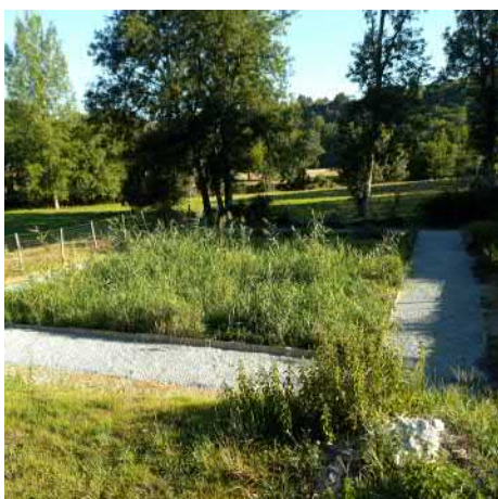
Rénovation station à La Ribière
