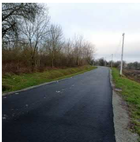
Rénovation voirie "petits breuils"
