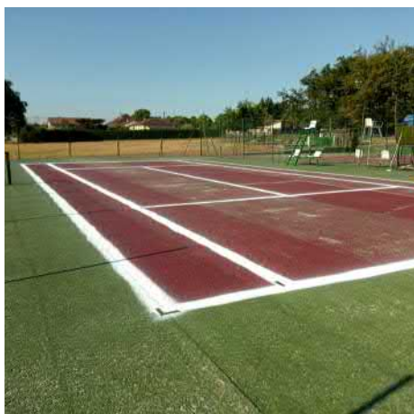
Nettoyage et reprise de la peinture sur un terrain de tennis
