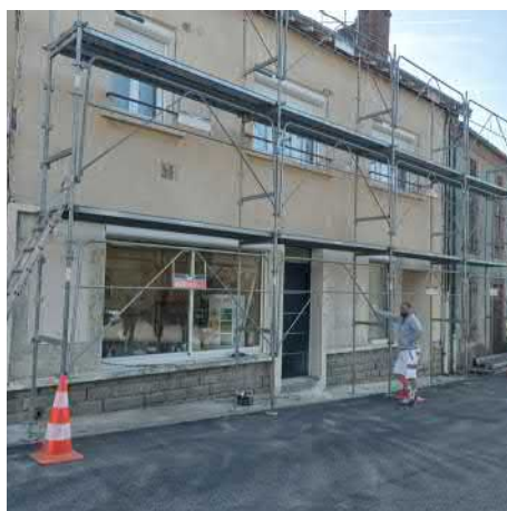
Réfection façade bâtiment
