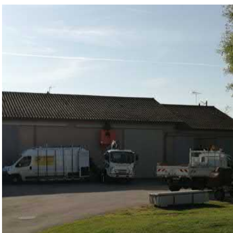
Réparation porte de garage
