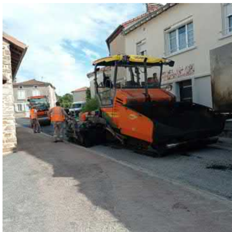
Réfection "rue de la Colline"
