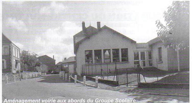
Aménagement voirie aux abords du Groupe Scolaire
