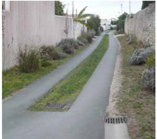
Loix ne dispose d'aucun réseau d'assainissement des eaux pluviales. Pour favoriser la quantité d'eau dans la nappe, l'infiltration directe est privilégiée plutôt qu'un réseau rejetant l'eau à la mer après traitement comme cela se fait dans les autres communes.
