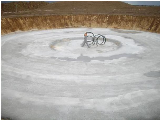
Dans chaque fond de fouille est ensuite coulé un béton « de propreté » sur lequel sera édifié le massif en acier et béton qui supportera l'éolienne
