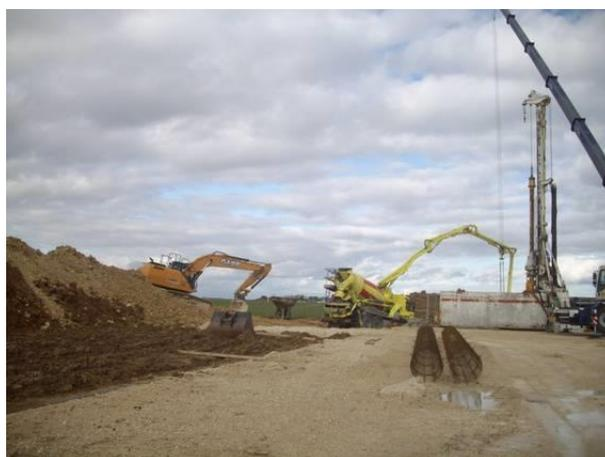
Une toupie installée à poste fixe est munie d'une pompe et d'une girafe. Elle est chargée d'assurer le transport du béton jusqu'aux coffrages
