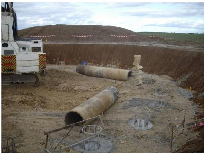
Compte-tenu de la nature du terrain, il s'est avéré nécessaire de renforcer le massif de 2 des 5 futures éoliennes par des piliers. D'un diamètre de 0,80m pour une profondeur de 14m, ils sont disposés en cercle dans le fond de l'excavation à raison de 20 par massif.
