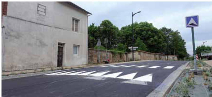
Des parkings et des ralentisseurs dans un cadre enjolivé. En haut de page: le chantier de la maison médicale (ici en juin) devrait se terminer fin septembre.
