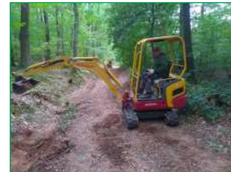
Curage et réfection de fossés
