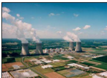
Centrale de Dampierre-en-Burly
