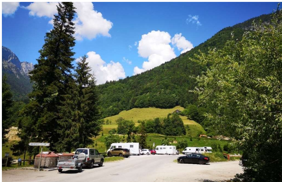
Perception sur la partie Ouest du site, depuis la route de Thuy : le lac (à gauche) et l'aire de camping-cars, surplombés par les remblais.
