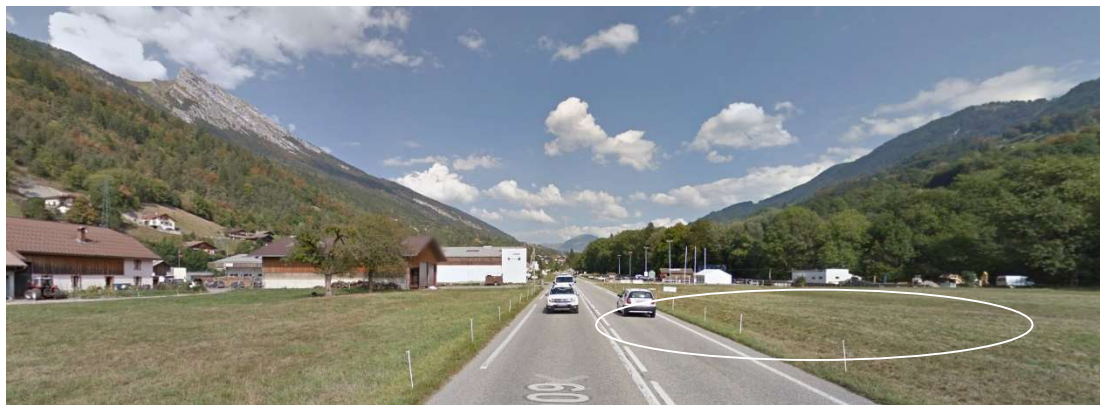
Le secteur du karting vu depuis la RD909 en direction des Aravis...
