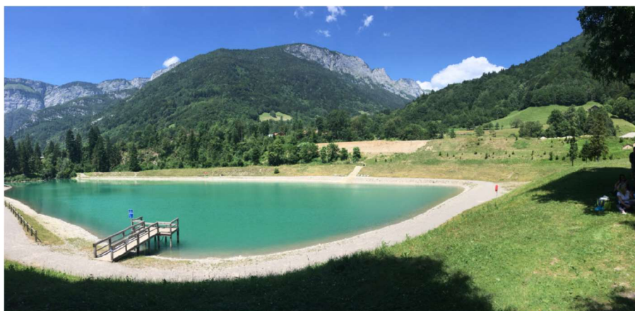
En partie Ouest du site : le lac et ses rives artificielles, surplombé par les remblais
