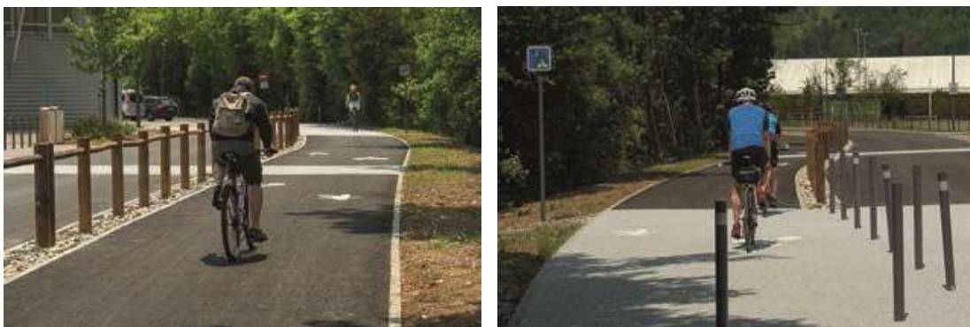
Voie verte entre le lac de Thuy, le collège des Aravis et le centre-ville de Thônes
