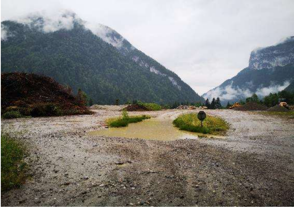
15. En partie Nord du site : depuis la route de Thuy, le site de décharge des déchets inertes
