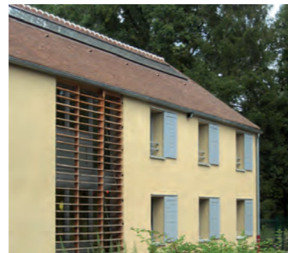
Un ensemble de capteurs thermiques souligne le faîtage de la toiture. Centre médicalisé à Bullion (Yvelines). Cabinet Méandre, architectes © PNR Haute Vallée de Chevreuse
