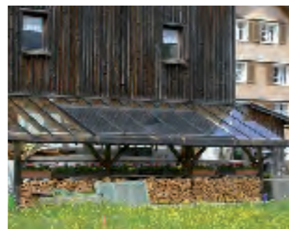
Les capteurs sont intégrés à la couverture d'une remise à bois. Maison individuelle (Vorarlberg, Autriche) © PNR du Vexin français
