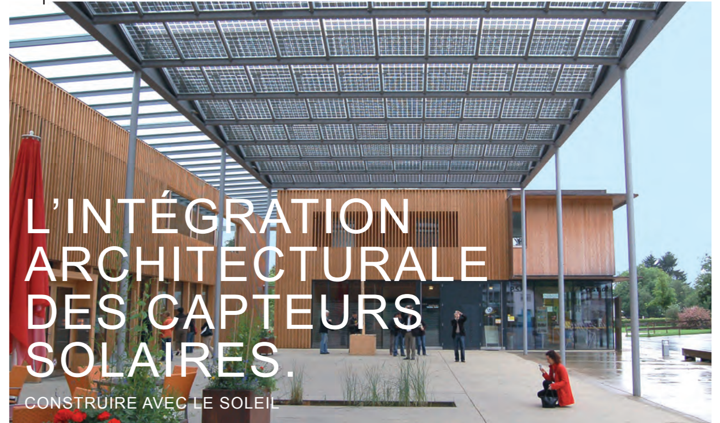
Un vélum de capteurs photovoltaïques abrite une place publique. Ludesch (Vorarlberg, Autriche) © CAUE 78
