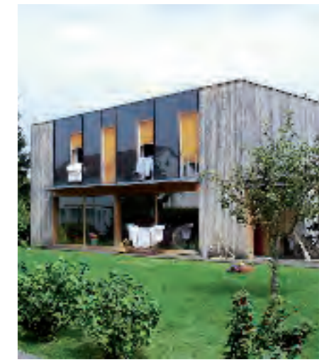
Les capteurs posés verticalement participent pleinement de la composition de la façade. Maison individuelle à Wolfurt (Vorarlberg, Autriche) © CAUE 78
