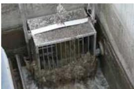
De plus en plus souvent, ces dysfonctionnements ou pannes des équipements ont **pour cause la présence de lingettes jetées dans le réseau** : elles bouchent les canalisations, empêchent les pompes de refoulement de fonctionner...
