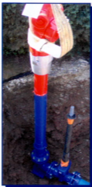
La mise en place d'un réducteur de pression : rue du Hohnack (du 23 au 29 avril)
