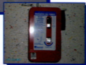
La mise en sécurité du système d'alarme à l'école Charles Perrault (du 23 au 29 avril)
