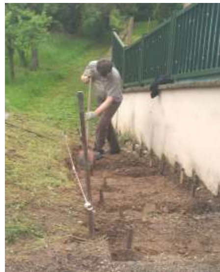
Aménagement du sentier Kirchhofpfad
