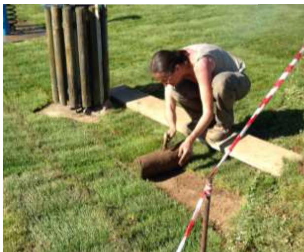
Pose du gazon à l'aire de jeux
