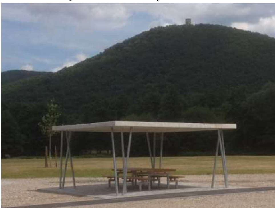
Pavage table couverte à l'aire de jeux : chantier terminé
