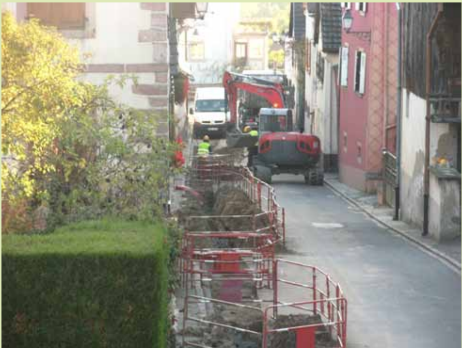
Travaux de mise en souterrain du réseau électrique 20 000 volts dans la rue Principale. La dépose de la ligne ainsi que la suppression des poteaux auront lieu ce printemps.
