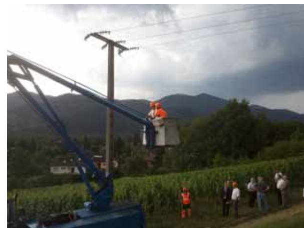
La dépose de la ligne 20 000 volts (22 juin)
