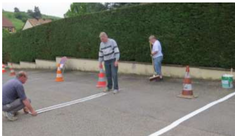
Marquage de places de parking
