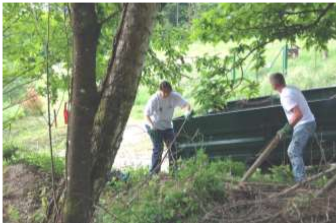
Nettoyage végétation au Germenweg
