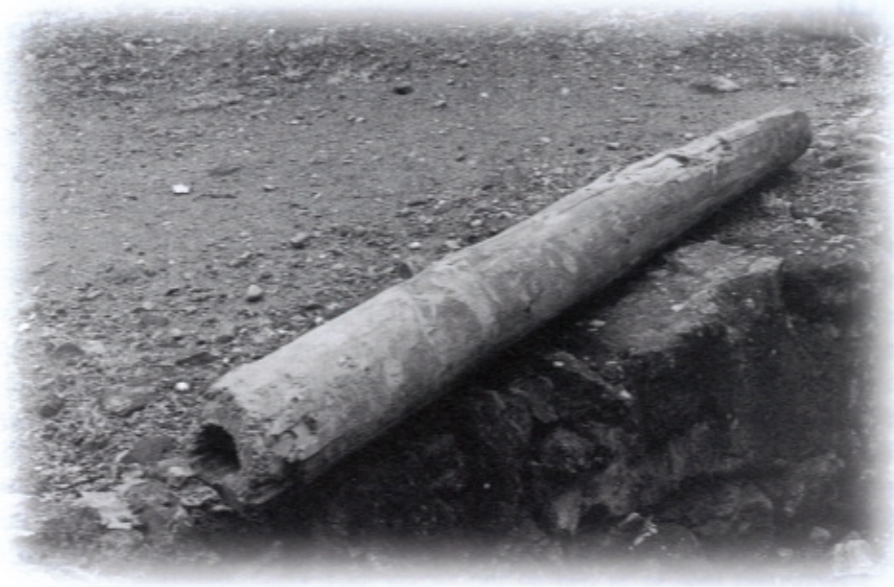
Conduite en bois qui alimentait les fontaines, lors de la réalisation de l'assainissement
