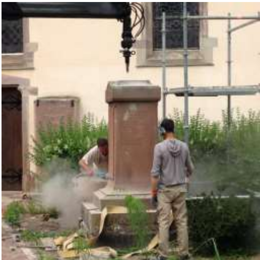
Quelques photos du chantier...
