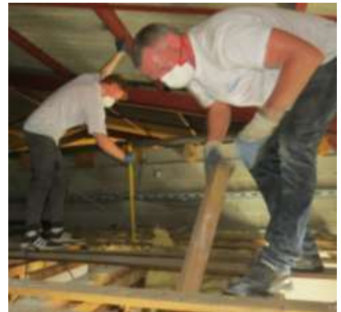
Déconstruction de l'ancien local pompier
