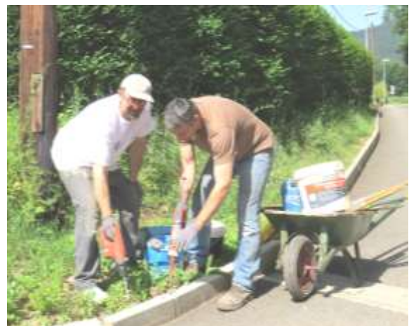
Réparation de bordures béton
