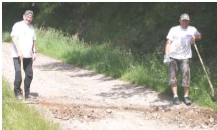
Remplacement des traverses dans les chemins
