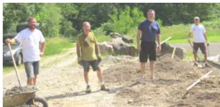
Création du parking PMR à l'aire de jeux
