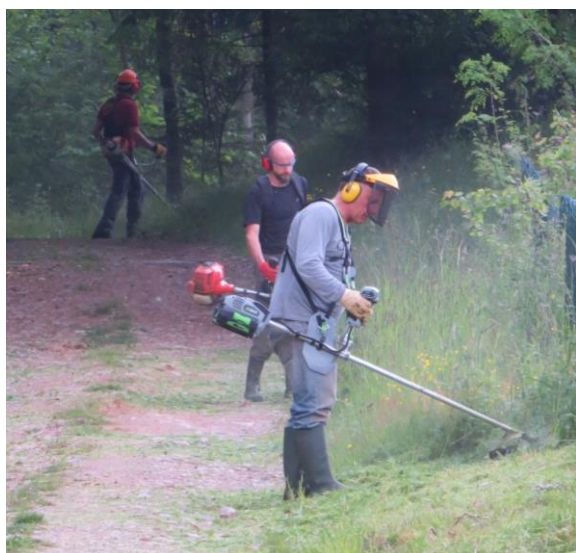
Travaux de débroussaillage
