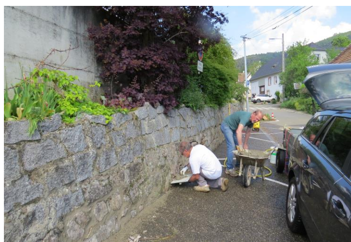
Réparation du mur de l'école
