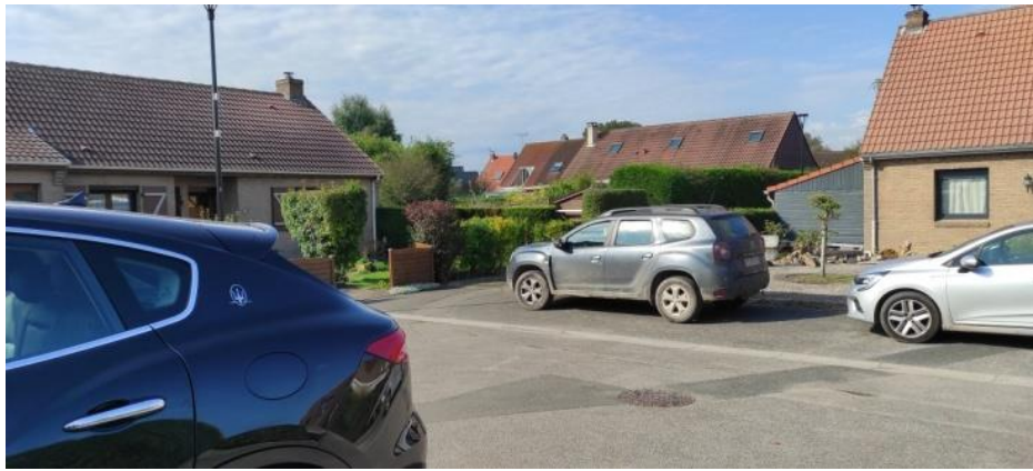
Photographies de la voie portion routière
