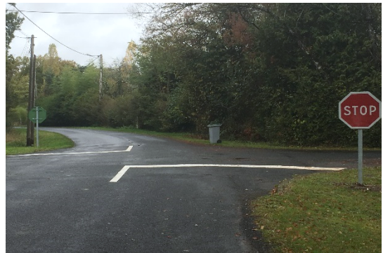
Sécurisation du Carrefour
